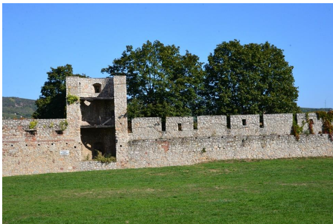
A külsővár szakasza a vártól északra
